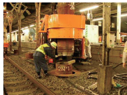
写真4 低空頭下での「ハイメカネジ™」施工状況
